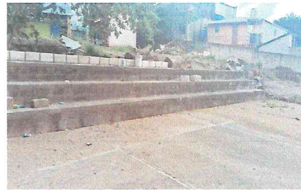
Foto 6: pegado de block, dos hileras para protección de la cancha, para que no se llene de agua.
