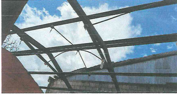
Foto1: Sustitución de lamina por lamina croquelada, en el area de la dirección y pintado de la estructura metálica.
