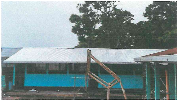
Foto 3: Sustitución de lamina por lamina croquelada, de dos aulas.
